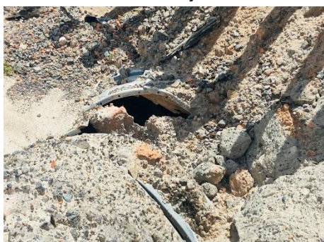
Figura 3: Abertura na interseção com a via férrea.
