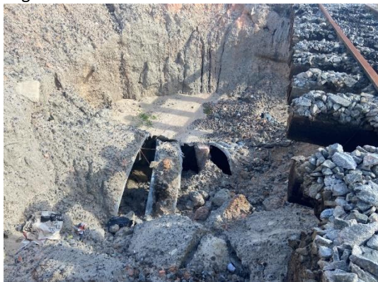
Figura 5: Túnel Liner existente
